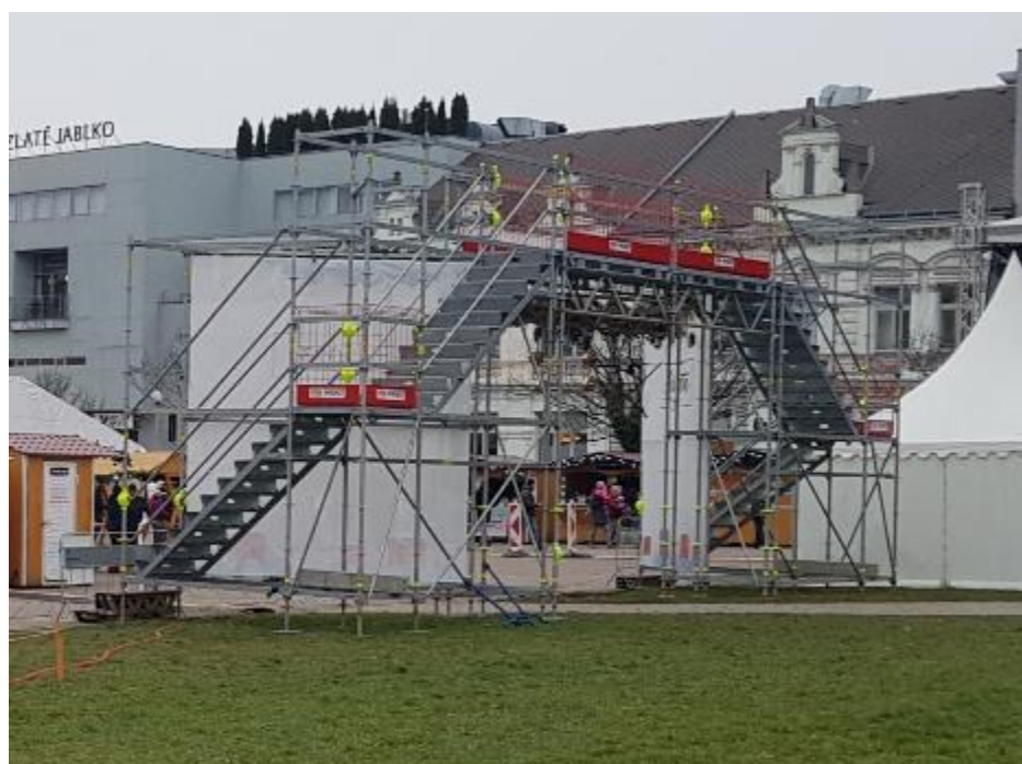
Obr. 10. Konstrukce rozhledny [Vlastní]
