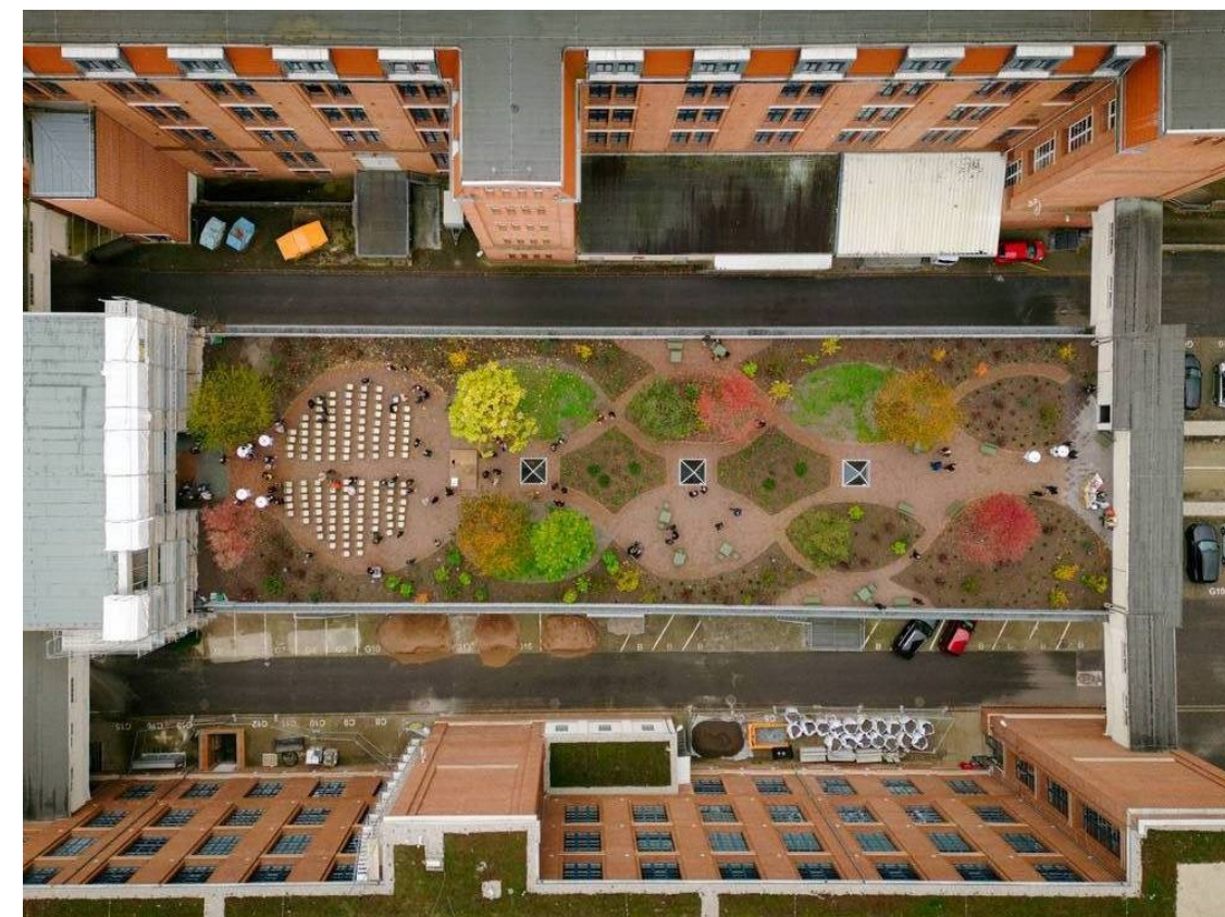
Obrázok 9 Wirkbau Chemnitz Roof garden (Richter, 2023)
