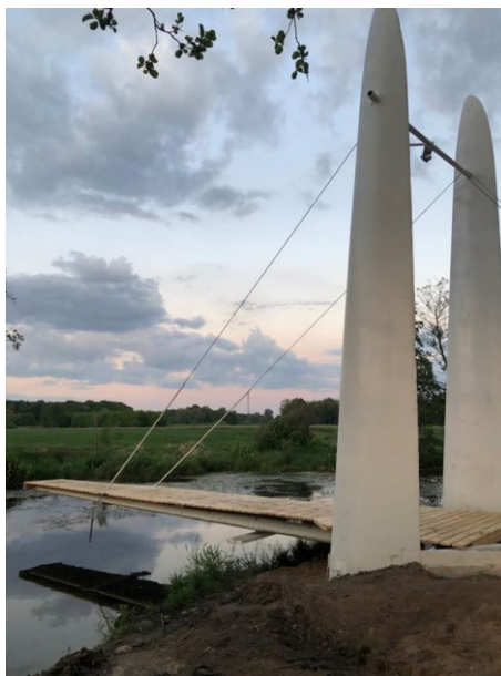
Obrázek 28 Visutá lávka z listů větrných turbín [28]
