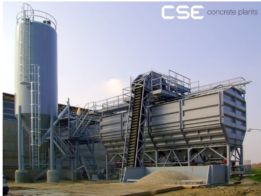
Obrázek 5: Sklad kameniva a cementu (Reference, ©2017)
