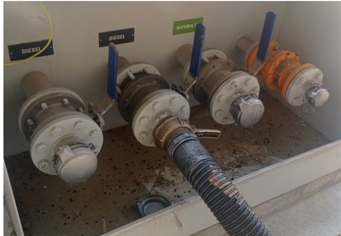
Obrázek 10 - Připojení stáček hadice na plnicí armaturu nádrže
