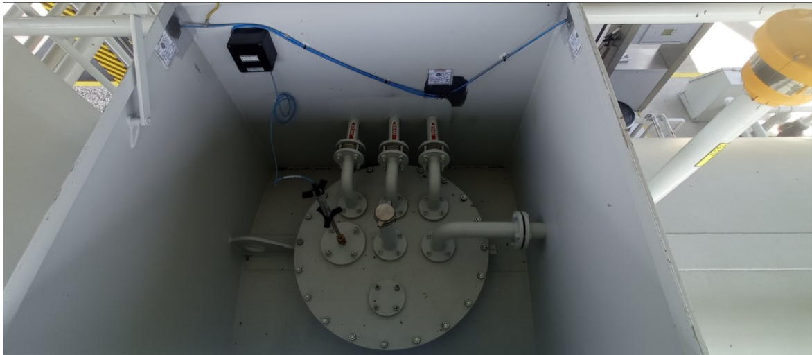
Obrázek 6 - Dóm zánovní nadzemní nádrže
