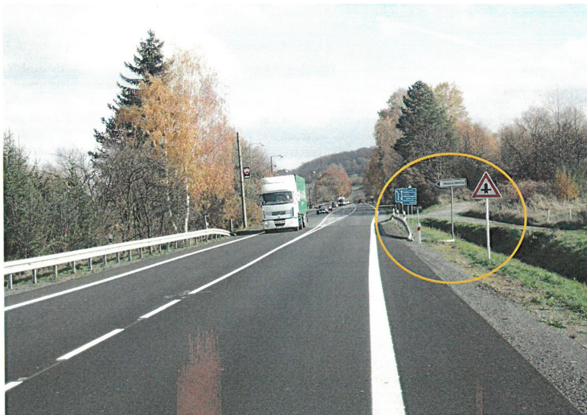
Obrázek 22 Nevhodné rozmístění dopravních značek (zdroj bezpečnostní inspekce, 2019)
