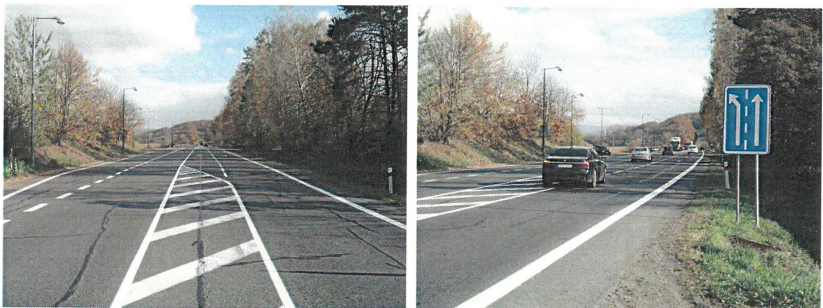
Obrázek 24 strmý náběh dopravního stínu (zdroj bezpečnostní inspekce, 2019)
