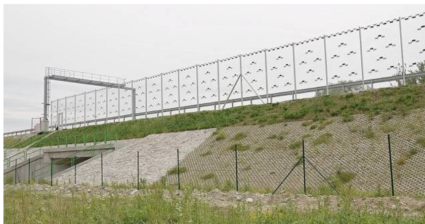
Obrázek 1 Průchozí bariéry proti ptactvu (zdroj ŘSD)
