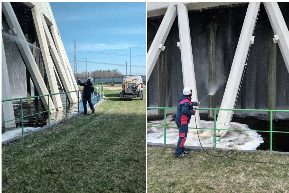
Obrázek 15. Ostřik sloupů chladicí věže
