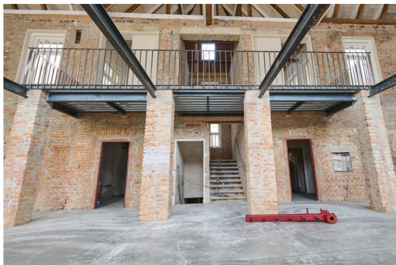
Obrázek 3: Foto z probíhající rekonstrukce areálu Vodoléčebného ústavu (zdroj: interní foto)
