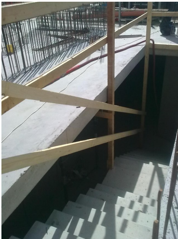
Obrázek 14 Dočasná konstrukce zábradlí (Zdroj: interní dokumentace společnosti)
