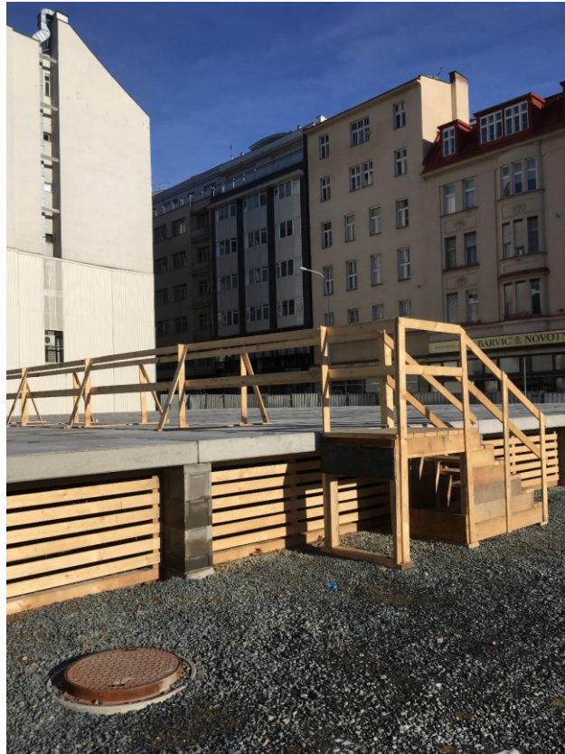
Obrázek 12 Zajištění proti pádu (Zdroj: interní dokumentace společnosti)
