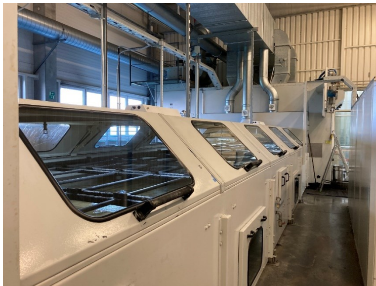
Obrázek 21 Vytékací tunel (interní zdroj)
