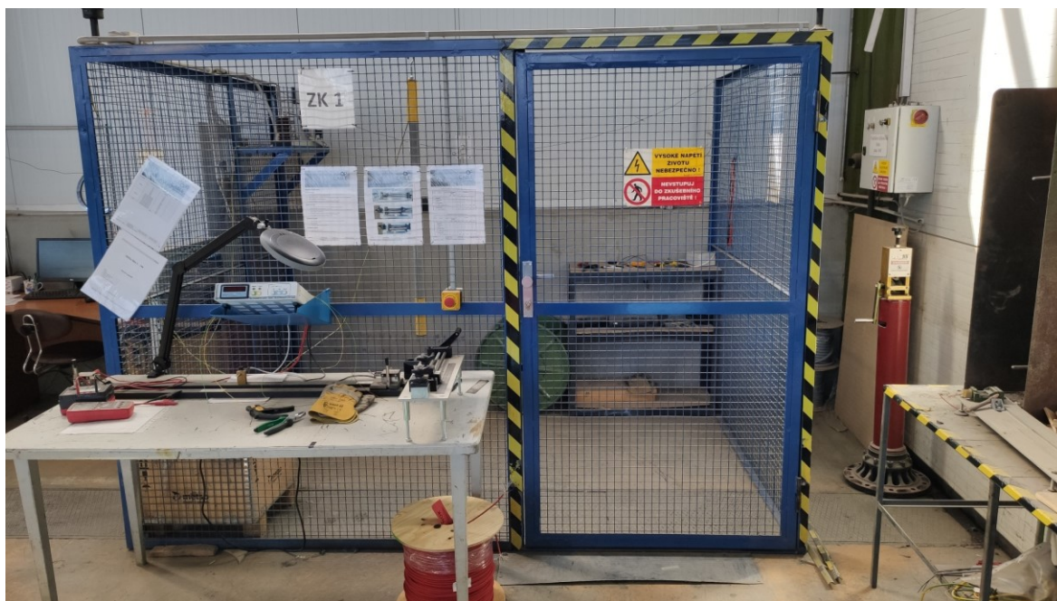
Obrázek 15 Elektro zkušebna (vlastní zpracování)
