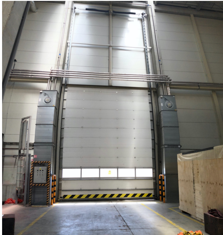
Obrázek 29 Vrata u prostoru lakovny (vlastní zpracování)
