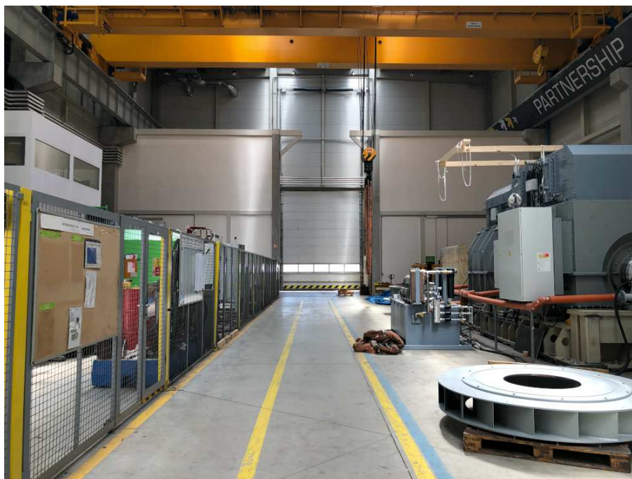
Obrázek 25 Vysokonapěťová zkušebna (vlevo) a navrhované umístění A (vpravo vzadu) (vlastní zpracování)
