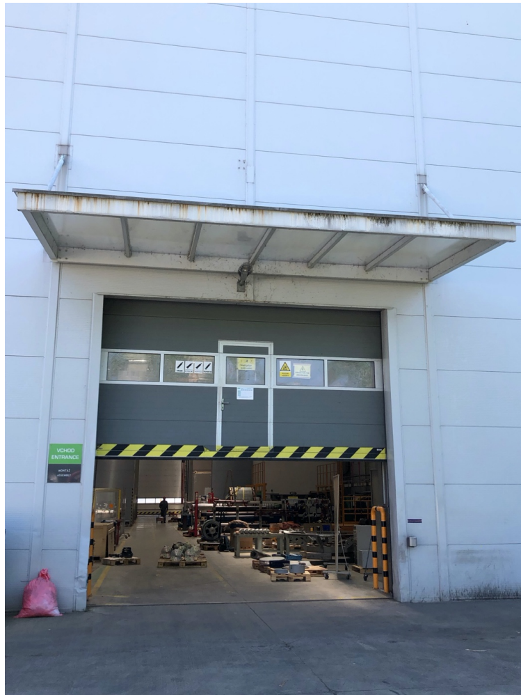
Obrázek 22 Vrata z odlehle strany budovy (vlastní zpracování)
