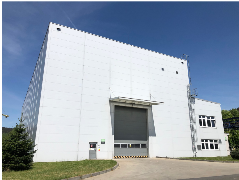
Obrázek 19 Hala Elektromontáže III a VN zkušebny (vlastní zpracování)
