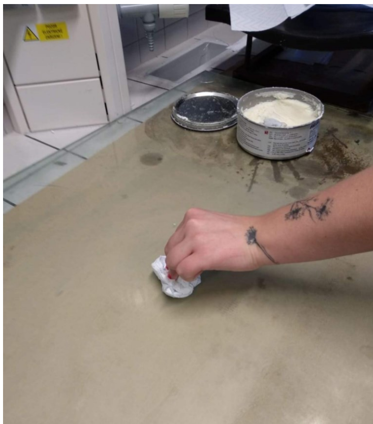
Obrázek 54 Nanášení separátoru na povrch formy
