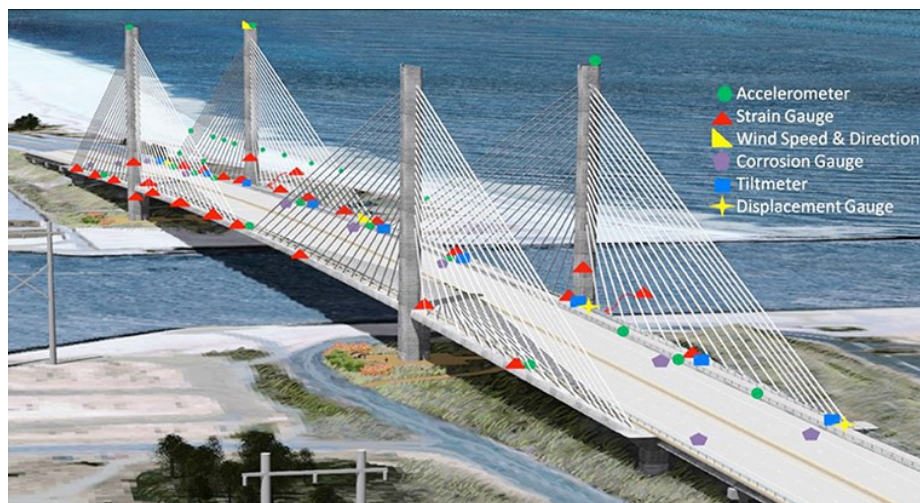
Obrázek 8 Monitorování stavu mostní konstrukce pomocí sensorů [11]
