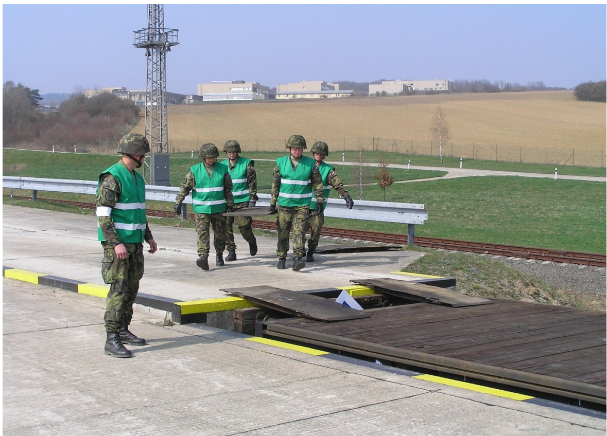
Obr. 17 Přemostění mezi nakládací rampou a železničním vozem
