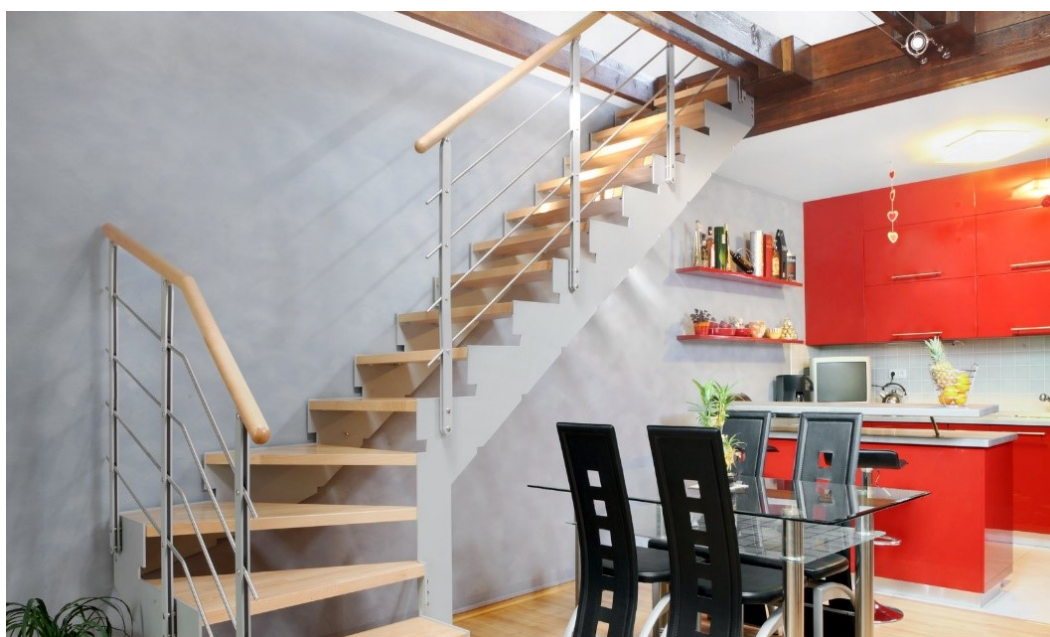
Obrázek 26 Ukázka nerez zábradlí s dřevěným madlem (interní materiály)
