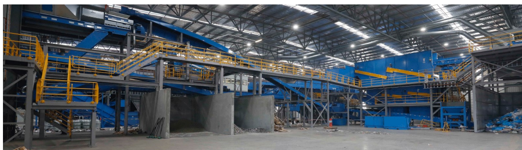
Obrázek 26 Panoramatický snímek vnitřního prostoru Perth material recovery facility (87)
