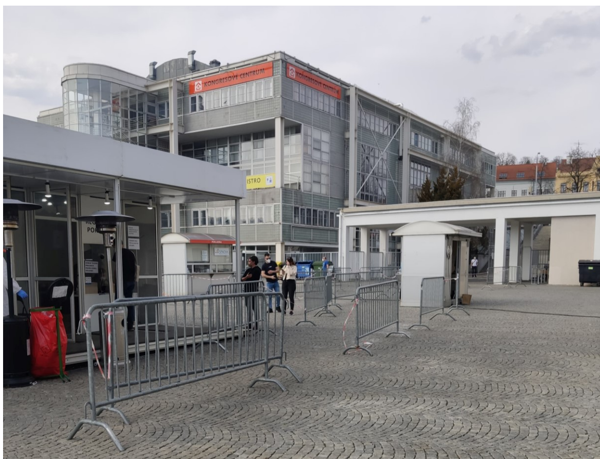
Obrázek 12 Využití mobilních bariér Brno [vlastní zdroj]
