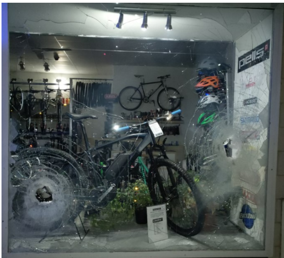
Obrázek 3 Výloha s bezpečnostní folií po zásahu výbušninou [11]
