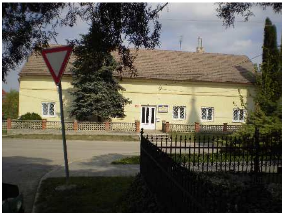
Foto budovy soukromého výchovného ústavu s.r.o. Troskotovice (archiv autora)
