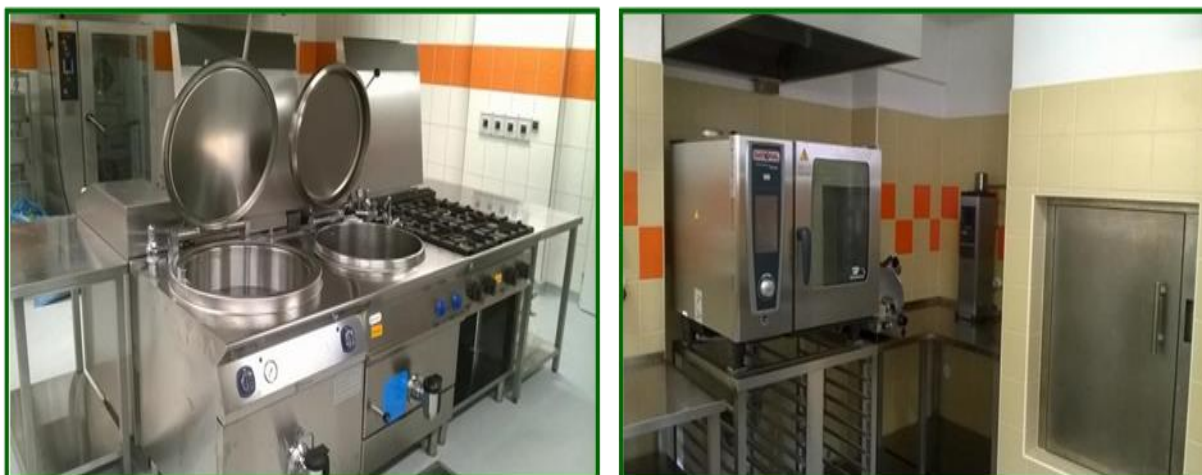
Obr. 5 Obnovené kuchynské zariadenie (Zdroj ULZ OS SR)
