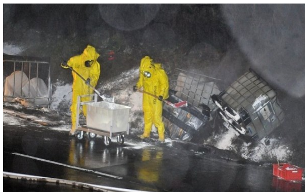
Foto 150. Hasiči pracují na neutralizaci kyseliny chlorovodíkové. [Zdroj: F-150]
