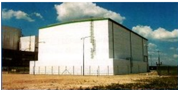
Obrázek 66. Sklad použitého paliva v JE Dukovany. [Zdroj: O-66]
