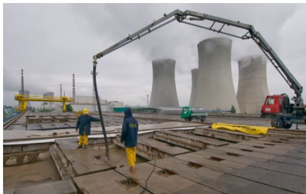
Obrázek 80. Betonážní jímka se sudy v úložišti JE Dukovany. [Zdroj: O-80]
