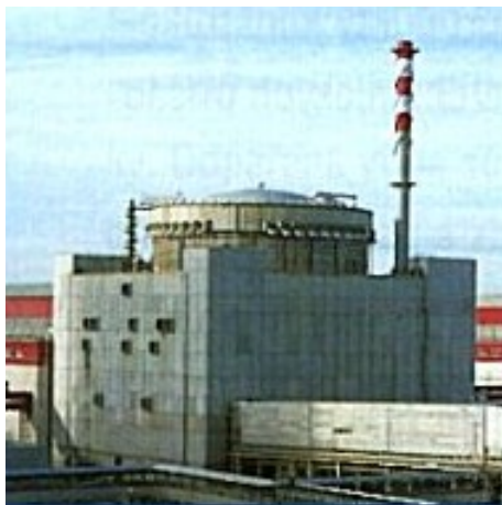
Obrázek 63. Kontejnment s reaktorem v JE Temelín. [Zdroj: O-63]
