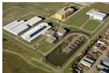
Obrázek 74. Sklad vyhořelého paliva a vysokoaktivních odpadů v nizozemském Vlissingen-Oostu. [Zdroj: O-74]
