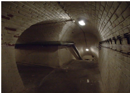
Foto 85. Úkryt civilní ochrany pod Špilberkem v Brně. [Zdroj: F-85]
