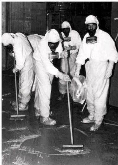
Foto 88. Pracovníci JE TMI při dezaktivaci v pomocné budově – 1979 jaderná havárie na JE Three Mile Island. [Zdroj: F-88]
