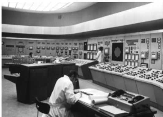
Obrázek 85. Velín jaderné elektrárny A-1. [Zdroj: O-85]
