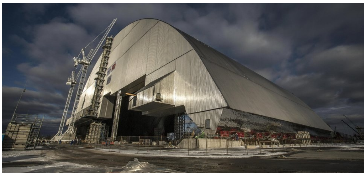
Foto 112. Nový kryt, který zakryl havarovaný energoblok. Autor: ČTK, EPA, REUTERS. [Zdroj: F-112]
