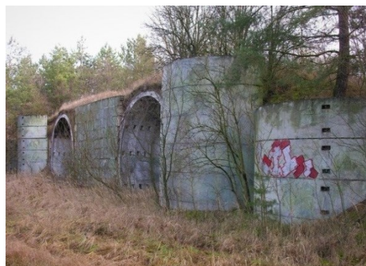
Foto 57. Sklad speciální munice letiště Boží Dar u Milovic. [Zdroj: F-57]
