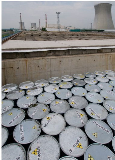
Obrázek 79. Jímka se sudy v Úložišti radioaktivních odpadů JE Dukovany. [Zdroj: O-79]
