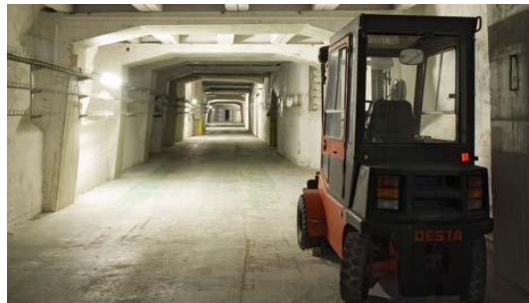
Obrázek 76. Chodba Úložiště radioaktivních odpadů Richard – Litoměřice. [Zdroj: O-76]
