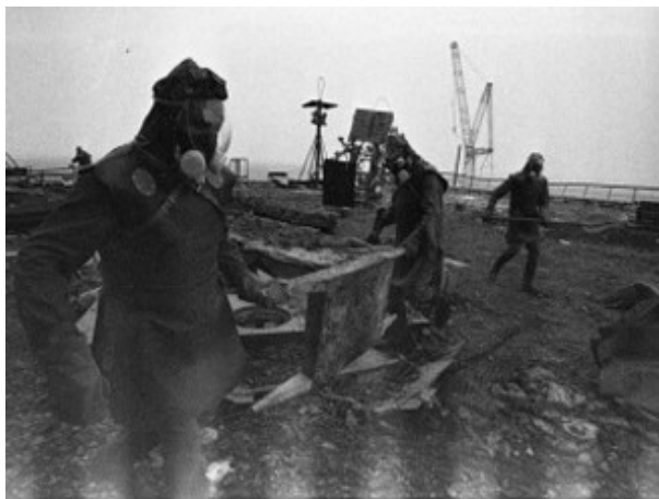
Foto 94. Bioroboti – vojáci, kteří rukama shazovali radioaktivní materiál ze střechy. Na spodní části fotografie je vidět radiaci. [Zdroj: F-94]
