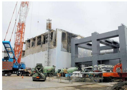
Foto 119. Stavba nové budovy, v níž budou uskladněné roztavené palivové tyče. [Zdroj: F-119]
