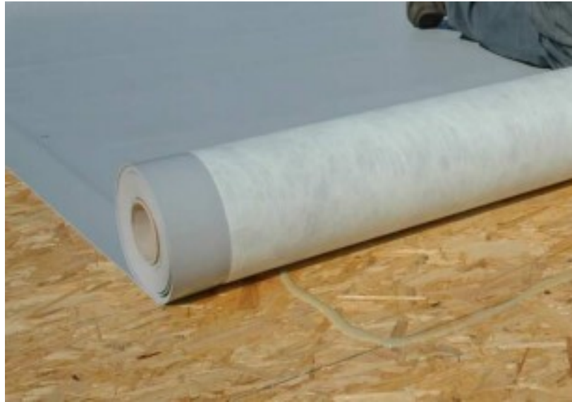
Obr. 1: Střešní hydroizolační fólie s netkanou textilií [4]
