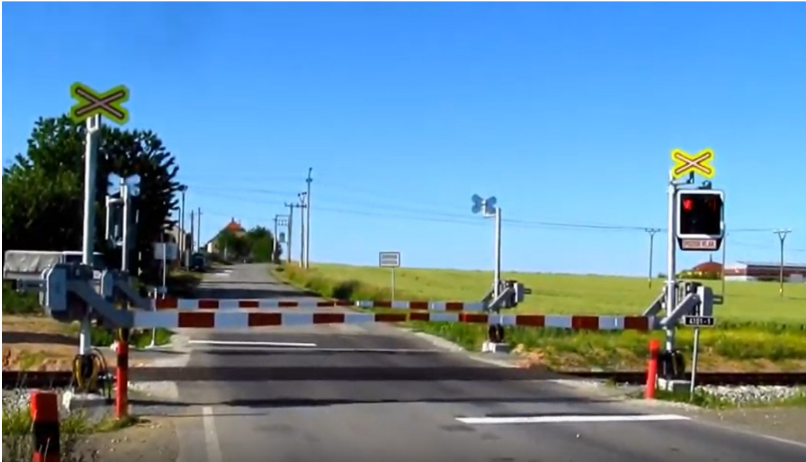
Obr. 19. Druhá fáze sklápění břevan při sekvenčním sklápění břevan
