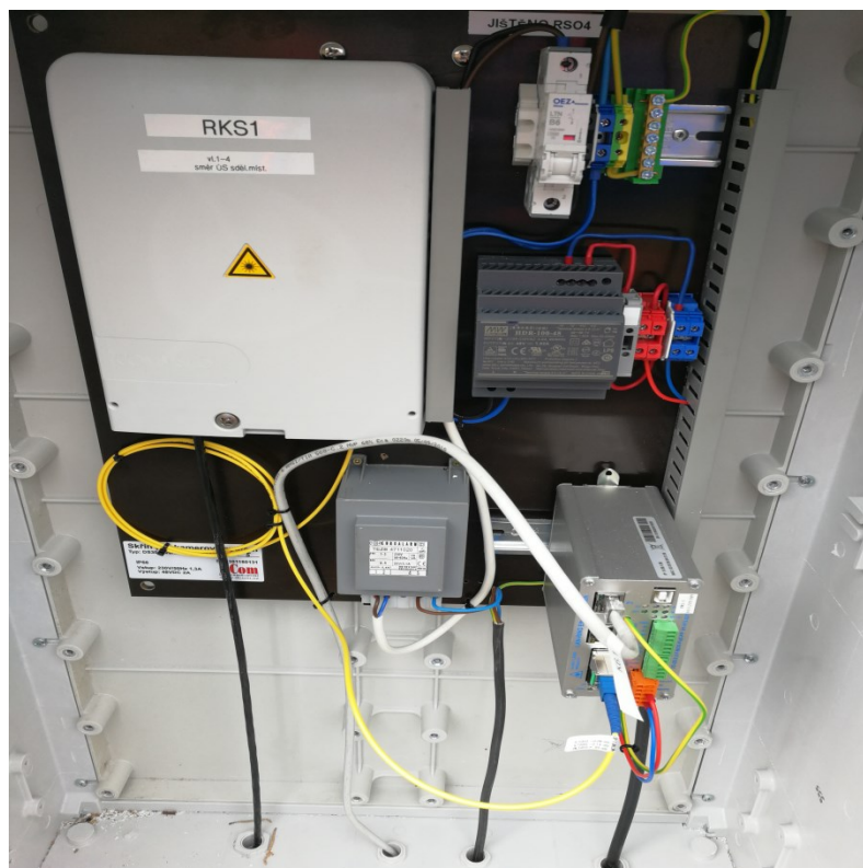
Obr. 48. Rozmístění zařízení v kamerové skříni
