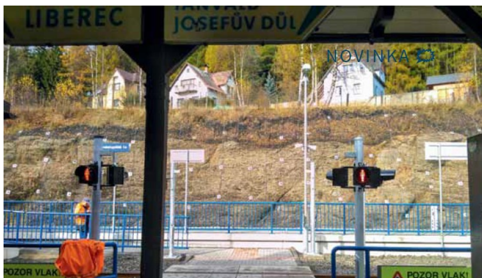
Obr. 17. Pohled na centrální přechod zabezčený VZPK [8]
