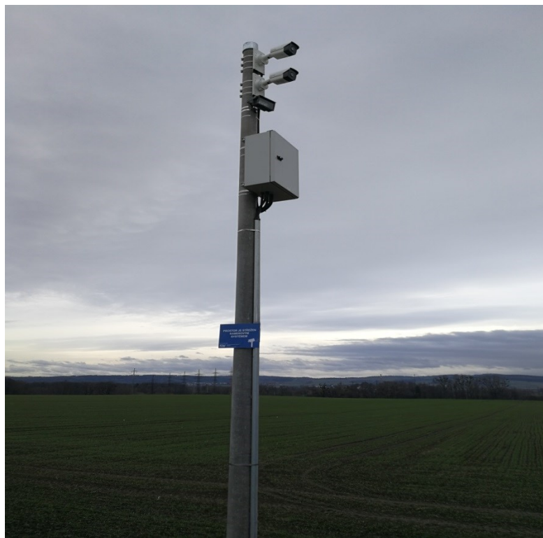
Obr. 47. Detailní pohled na kamerový sloup
