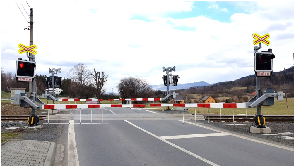
Obr. 14. Železniční přejezd doplněný o zarážku slepecké hole
