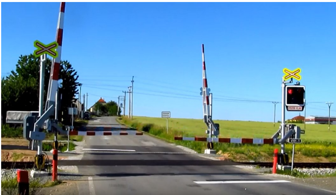
Obr. 18. První fáze sklápění břeven při sekvenčním sklápění břeven
