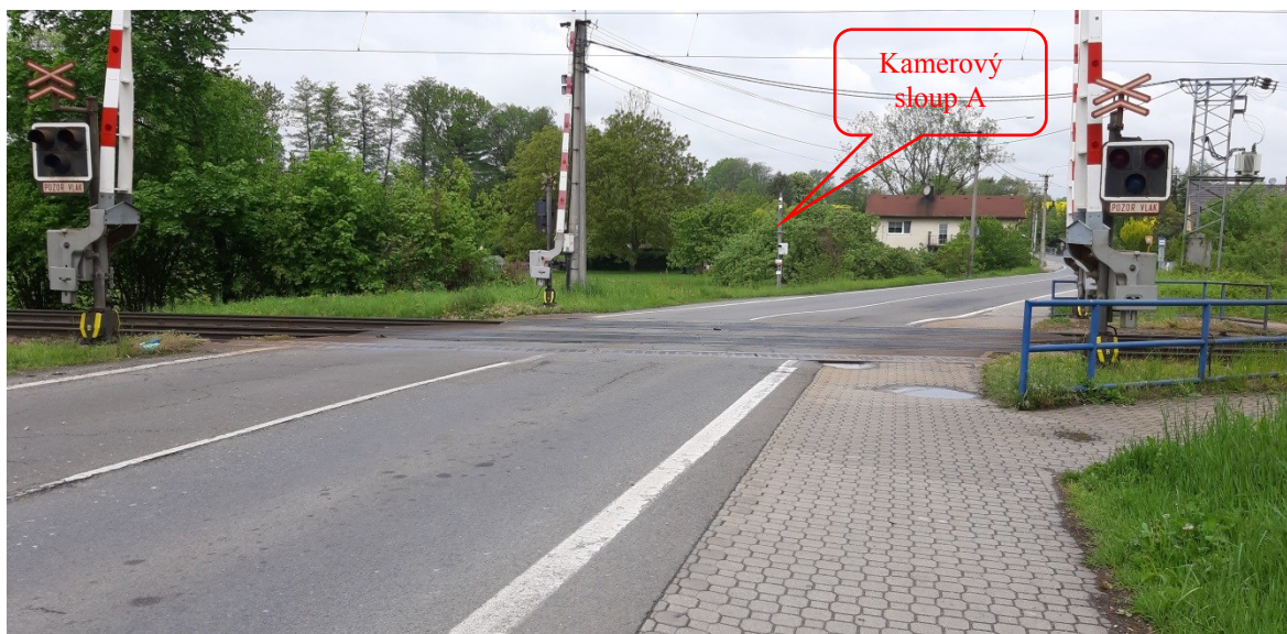
Obr. 45. Celkový pohled na umístění kamerového sloupu „A“
