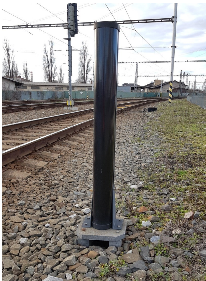
Obr. 28. Detailní pohled na infrazávoru
