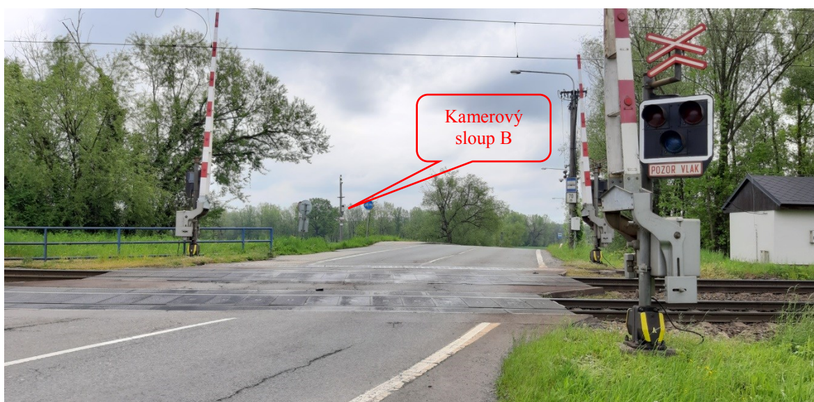
Obr. 46. Celkový pohled na umístění kamerového sloupu „B“
