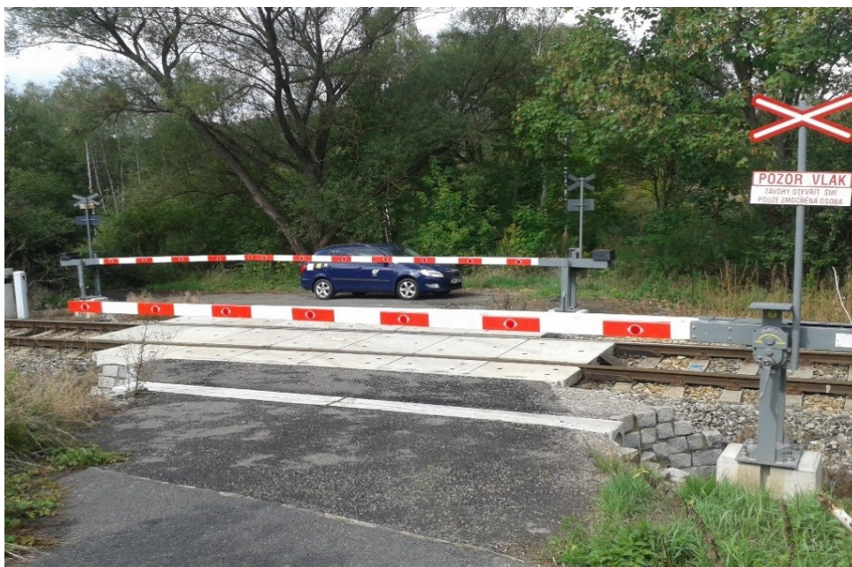
Obr. 3. Železniční přejezd zabezpečen PZM 2 [1]
