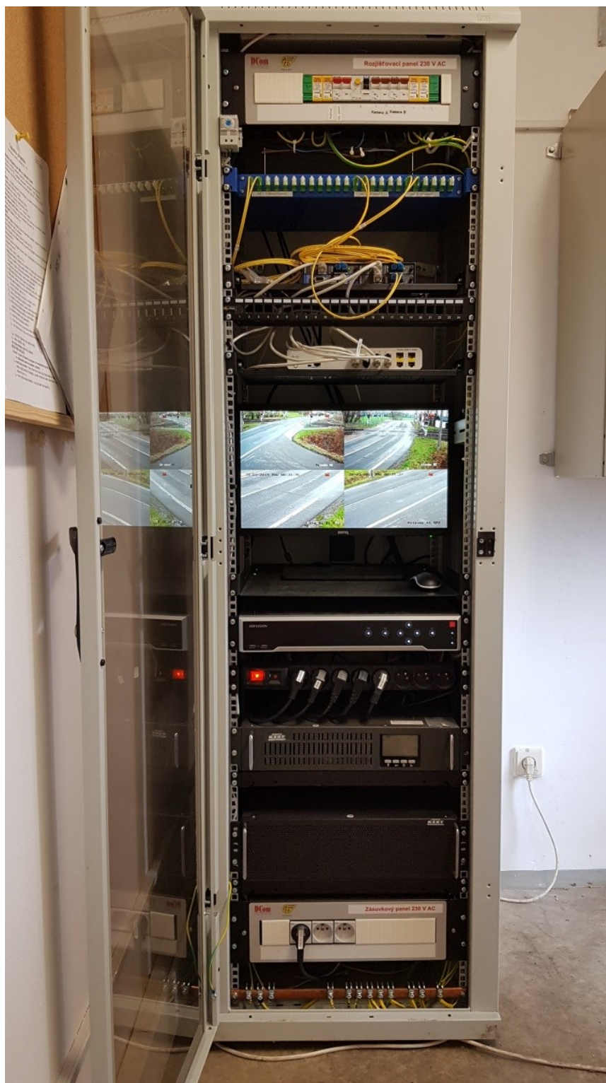
Obr. 49. Vnitřní výstroj kamerového systému
