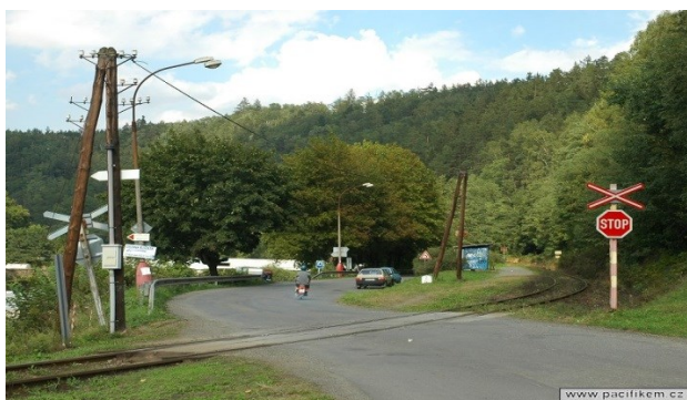
Obr. 1. Pasivně zabezpečený žel. přejezd
