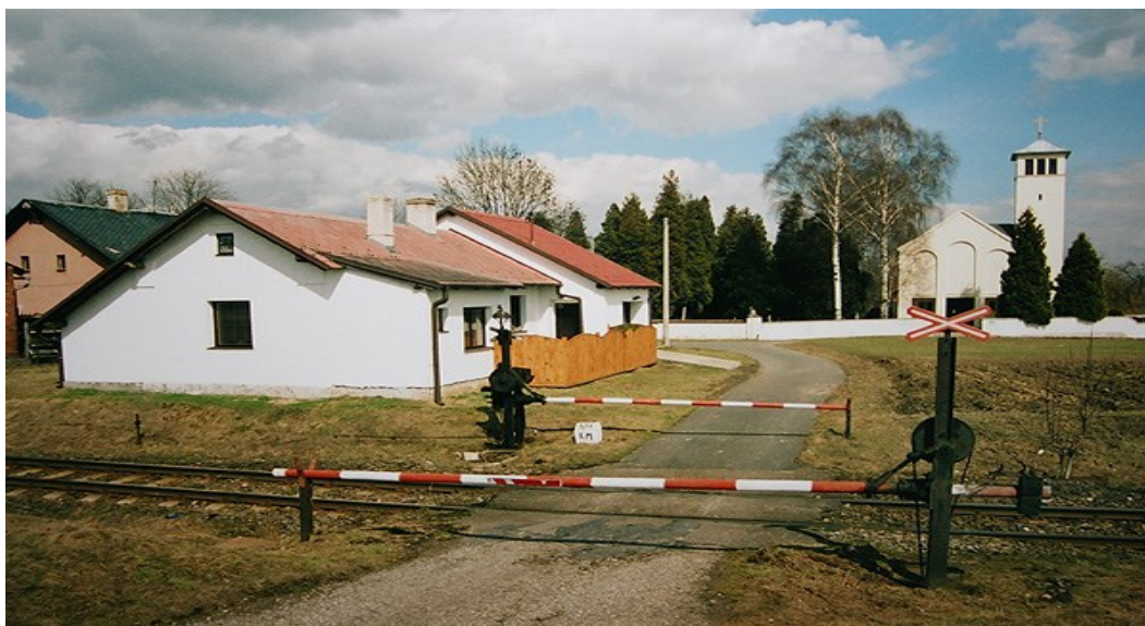
Obr. 2. Železniční přejezd zabezpečen PZM 1 [1]
