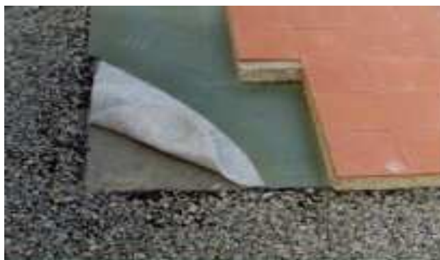
Obr. 3. Protiradonová fólie PENEFOL 800 [3]
