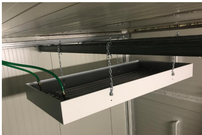
Obr. 6 Funkční vzorek chladicího stropu
