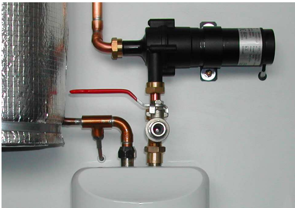
Obr. 4. Ventil pro napouštění a vypouštění vody.
