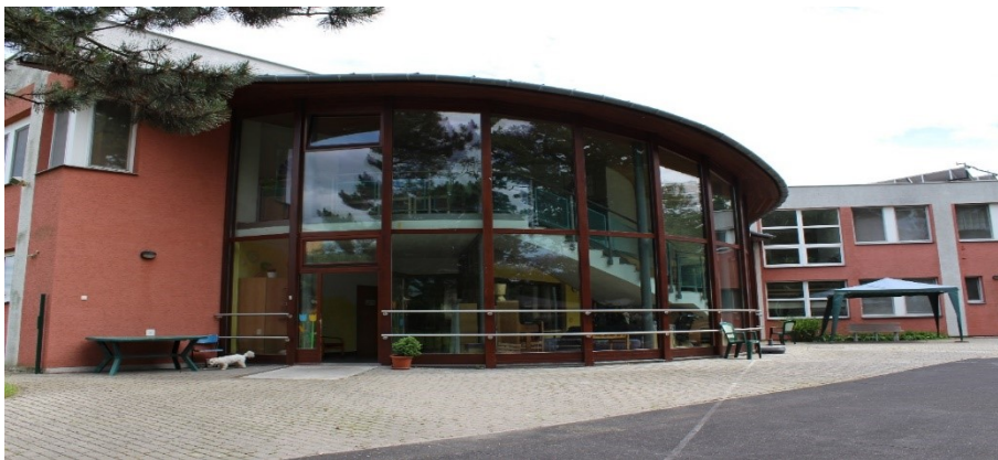
Obrázek 5 – Budova „A“ a „B“ [zdroj: vlastní]
