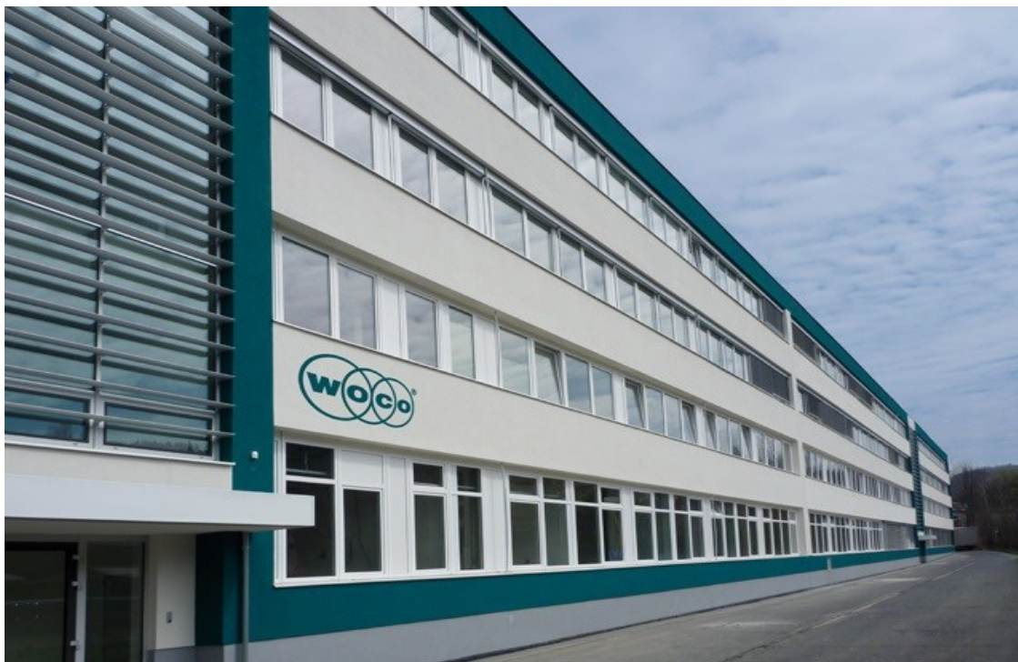
Obr. 26 Fotografie administrativní budovy společnosti WOCO STV s.r.o.
