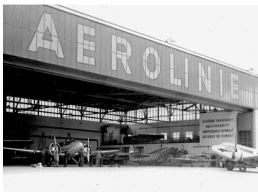
Obr. 21. Hangár společnosti ČSA
