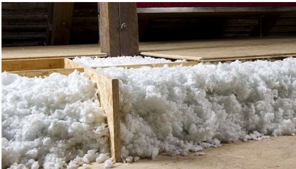
Obr. 6: Foukaná izolace pod podlahou půdy
