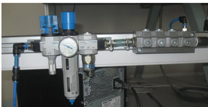
Obrázek 18: Přípojka stlačeného vzduchu a rozdvojka
