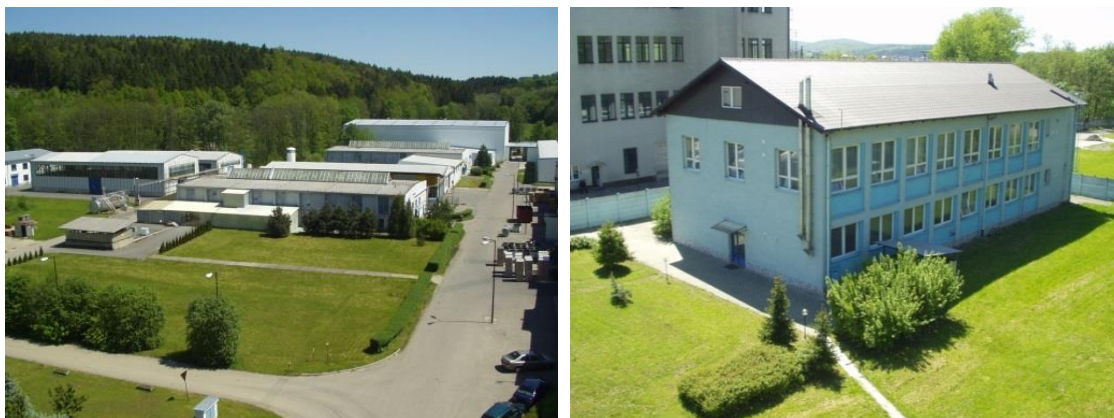
Obr. 10. Výrobní a administrativní budovy společnosti SCHLENK (interní materiály společnosti)
