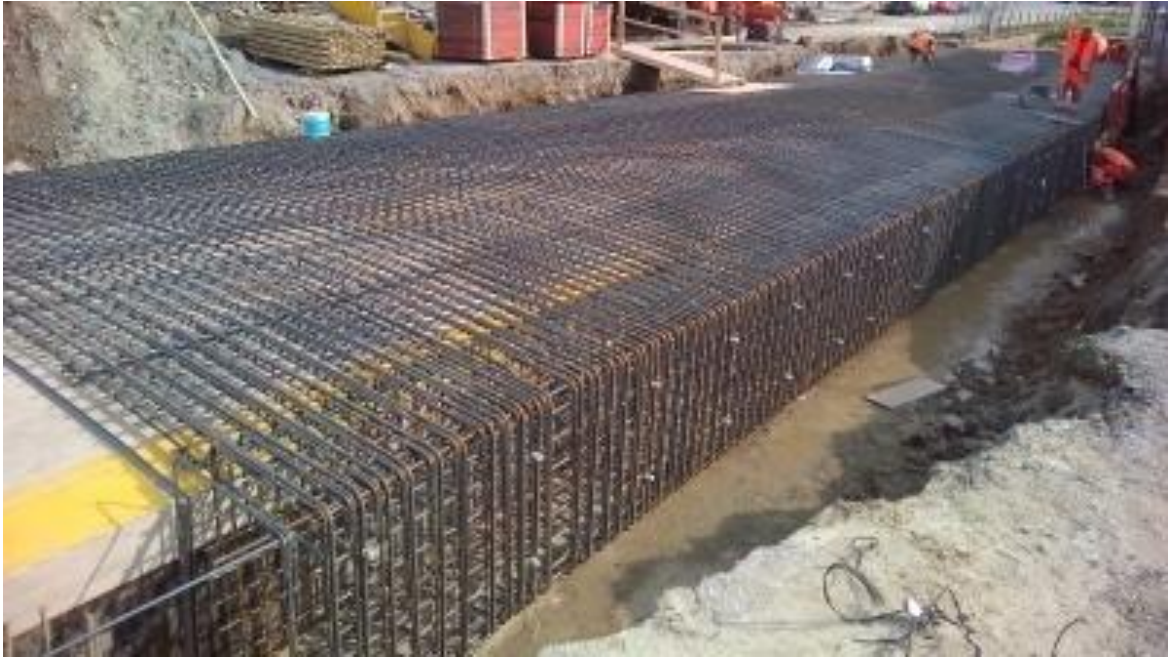
Obrázek 14: Příklad velké dodávky betonářské oceli (Mach)
