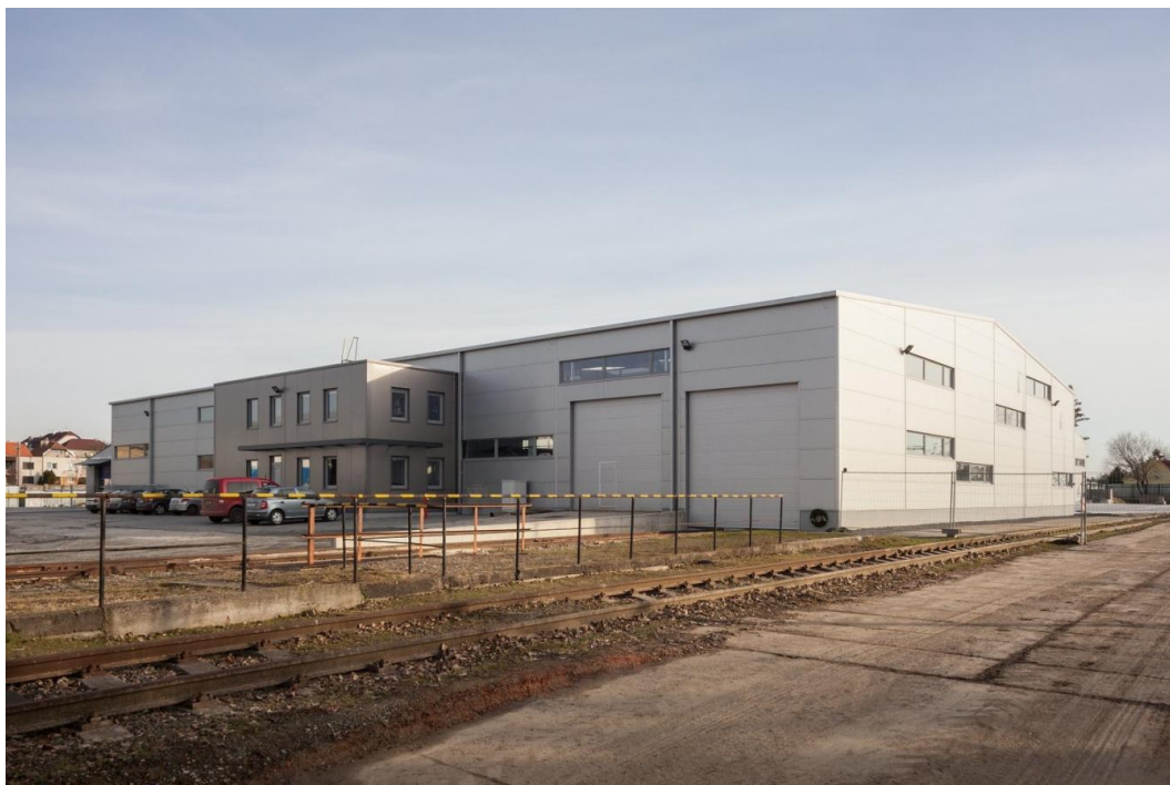
Příloha 3: Hala, kde probíhá stříh a ohyb, skladování i expedice
