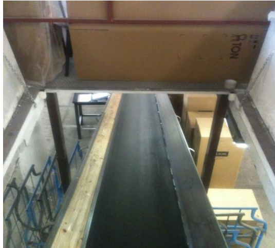
Obr. 15 Špatná viditelnost do skladových prostor (vlastní zpracování)
