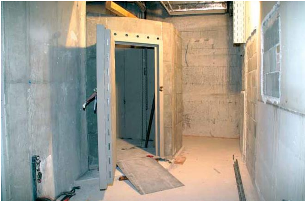
Obr. 10 Výstavba komorového trezoru [16]
