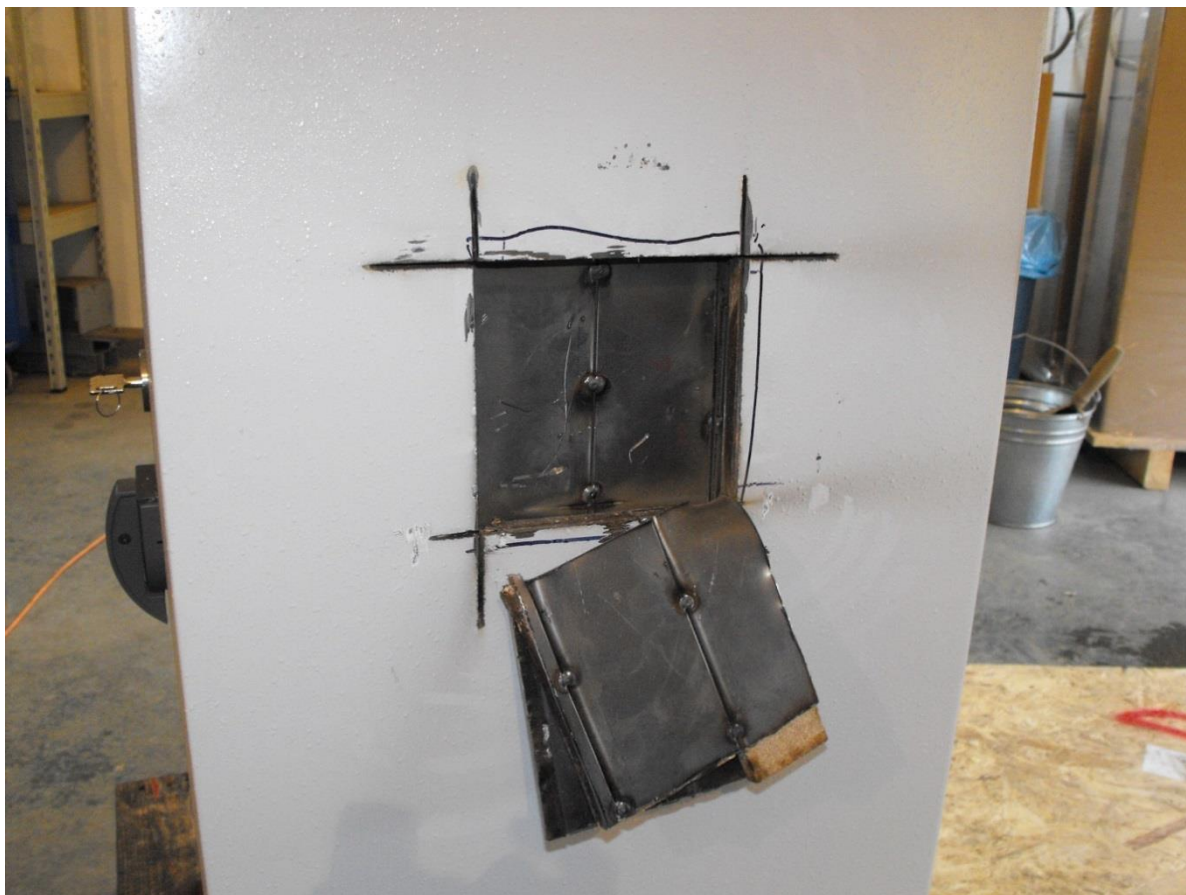
Obr. 21 Narušení vonkajšieho plášťa a časti výstužovej výplne
