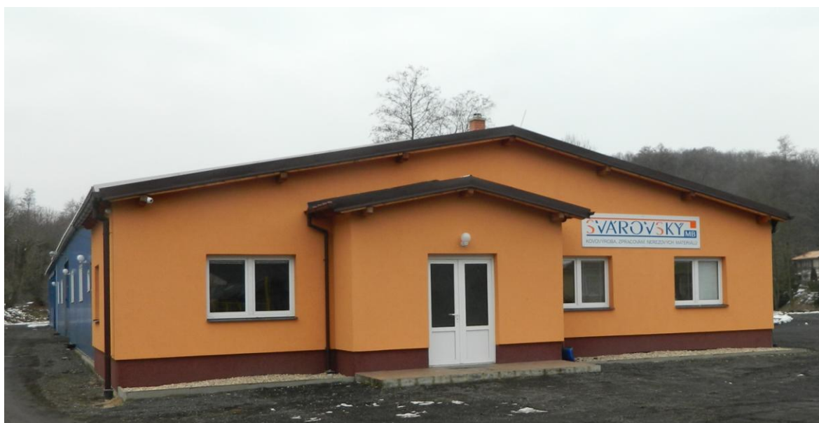
Obrázek 8: Sídlo firmy Svárovský MB, s.r.o. (Interní zdroj firmy)
