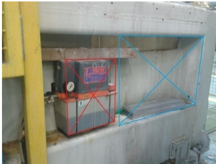
Obrázek 24 Prostor vedle vrtací stanice – místo pro umístění kalibračních desek (vlastní zpracování)
