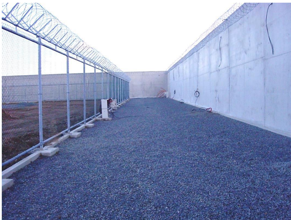
Obr. 1 Výstavba plotu, ohradní zdi a zakázaného pásma ve věznici s ostrahou [Zdroj: vlastní]
