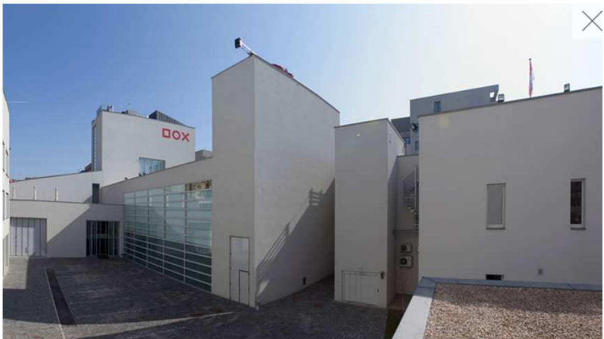
Obrázek 6. DOX před a po rekonstrukci
