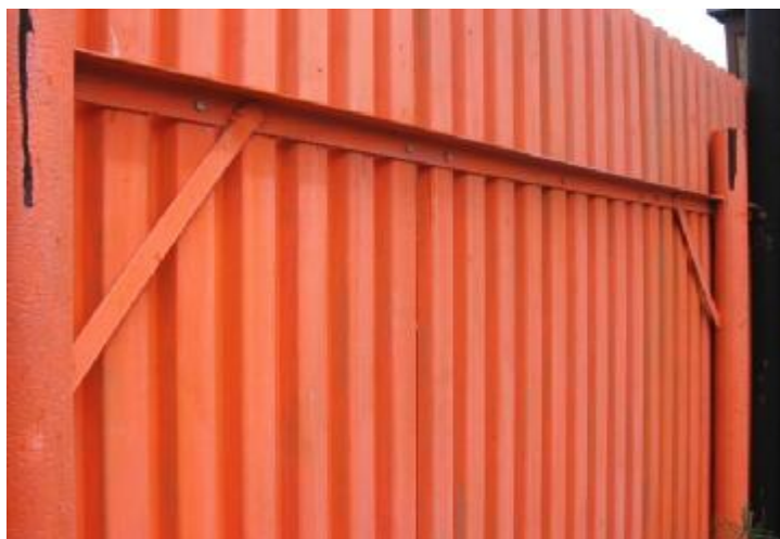
Obr. 44 Ocelová svařovaná konstrukce osazená ocelovými plechy
