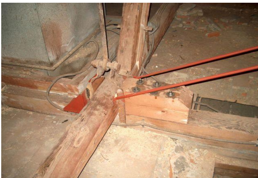
Obr. 14 Zpevnování dřevěné konstrukce
