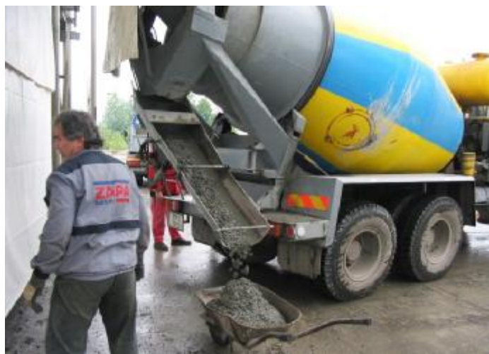
Obr. 38 Odebírání vzorku z betonové směsi
