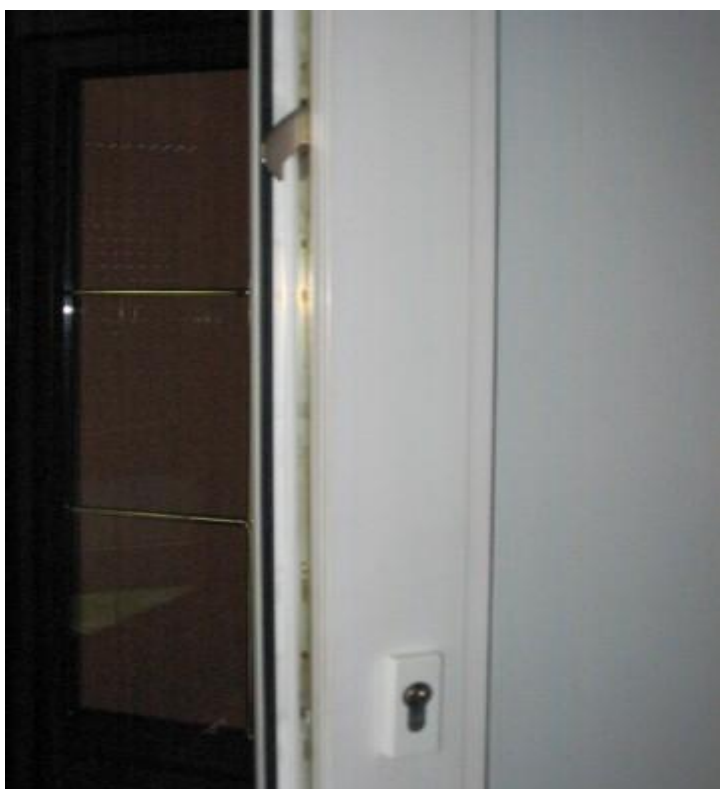
Obr. 48 Příkladná západka do rámu dveří v horní a dolní části dveří
