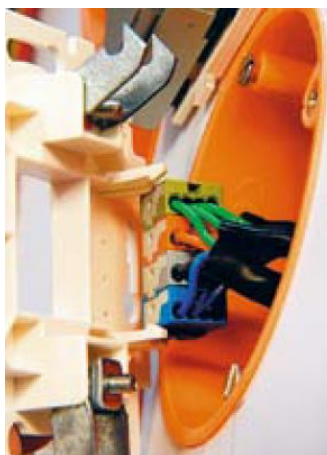
Obrázek 38 - Příklad zapojení prvku na primární sběrnici [23]
