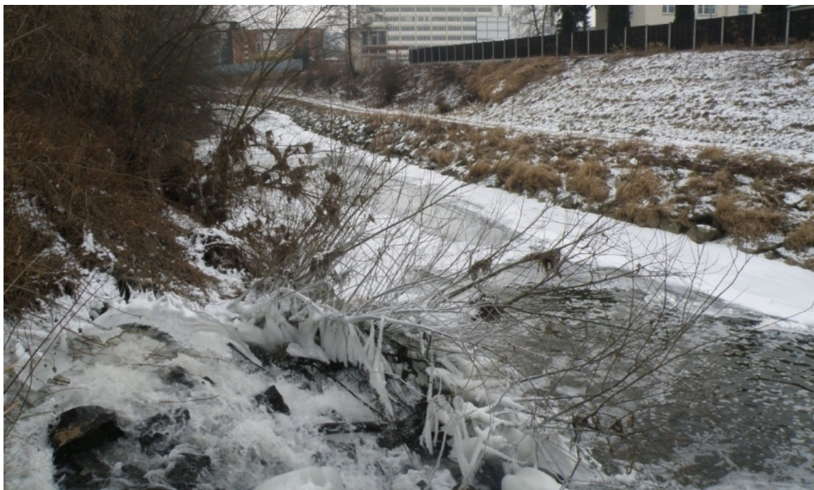
Obr. 9. Výpust' čistírny odpadních vod v Malenovicích
