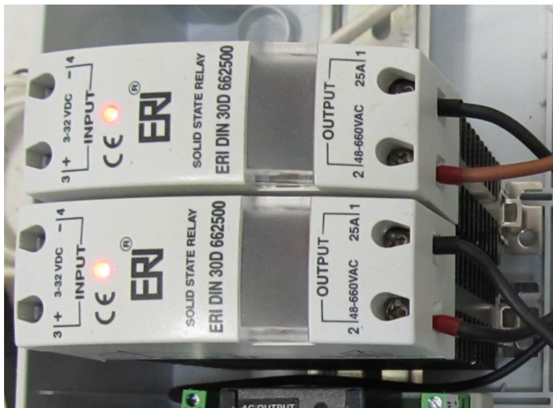
Obrázek 4 – Relé pro spínání topné spirály
