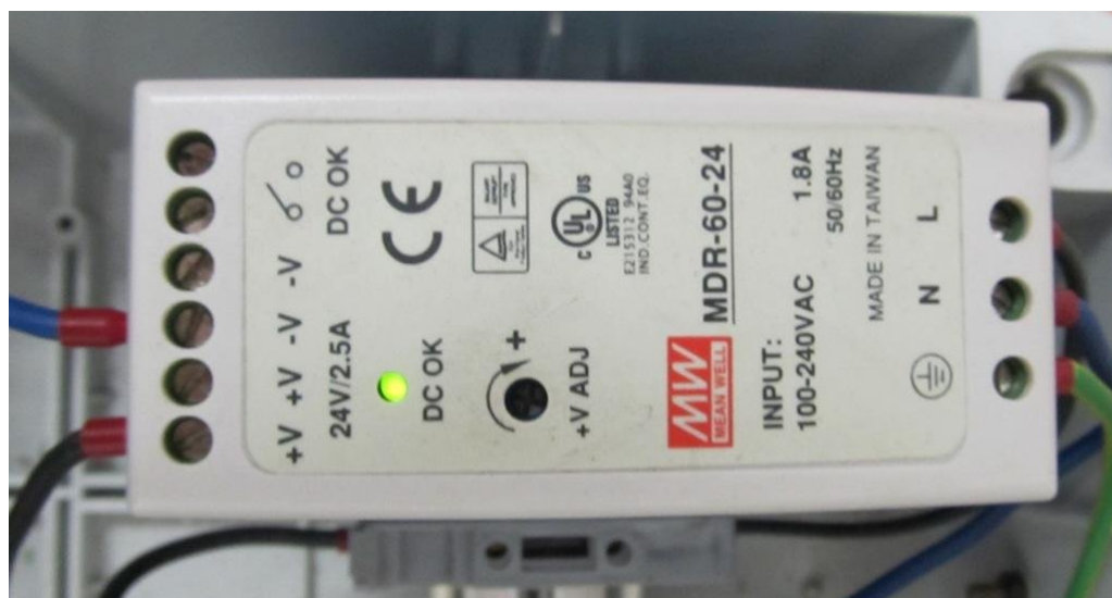
Obrázek 5 – Zdroj 24V pro napájení Elektroměru a Datalabu IO
