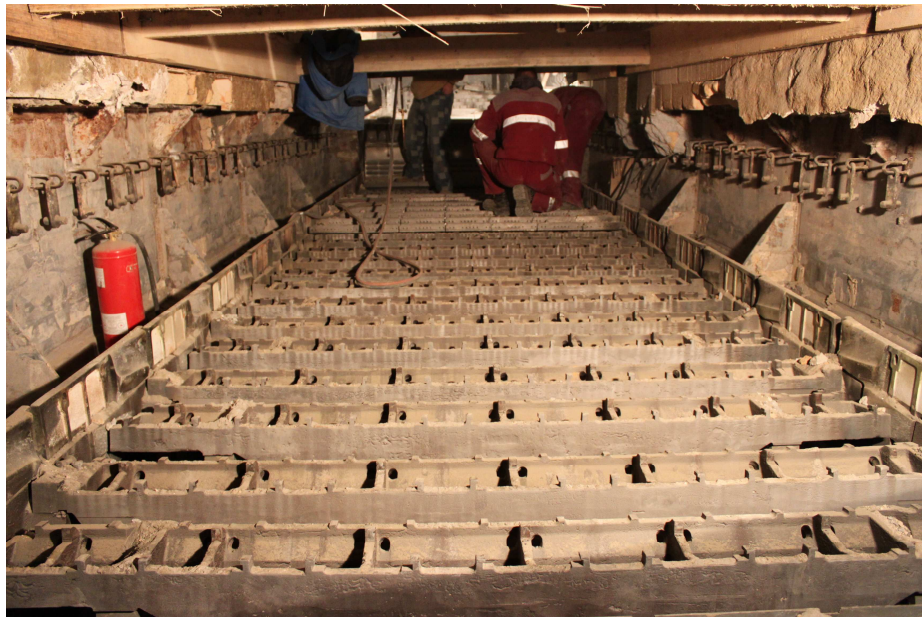
Obr. 54 Demontážne práce na chladiči (Vlastné spracovanie)
