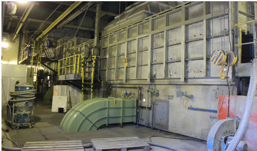
Obr. 58 Zrekonštruovaný chladič slinku (Vlastné spracovanie)
