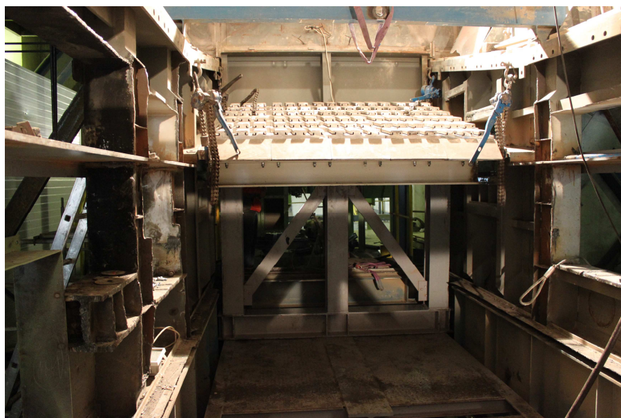
Obr. 55 Montáž modulov chladiča (Vlastné spracovanie)
