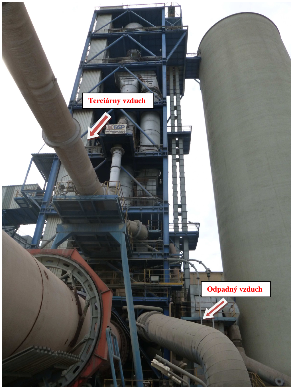
Obr. 31 Terciárne a odpadné potrubia (Vlastné spracovanie)
