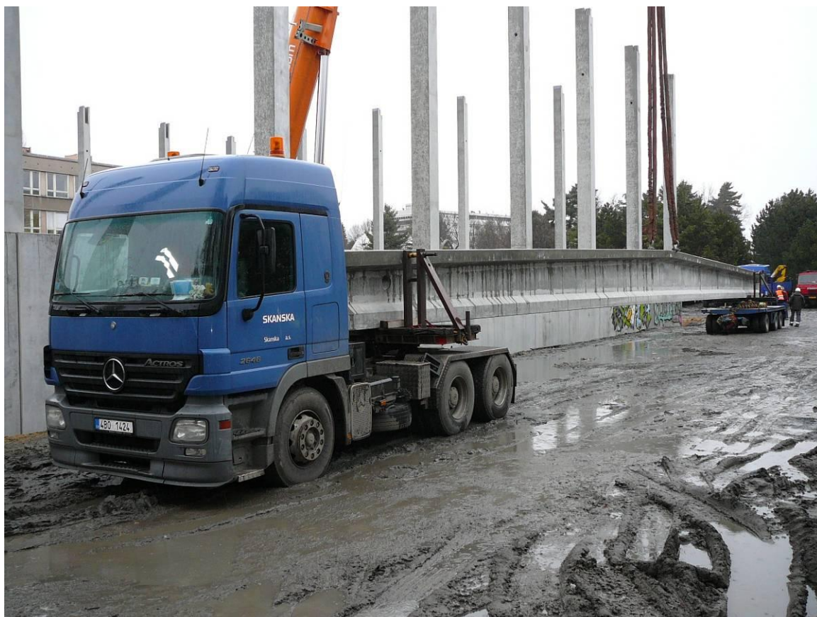
Obr. č. 8 Naložení vazníku na speciální soupravu
