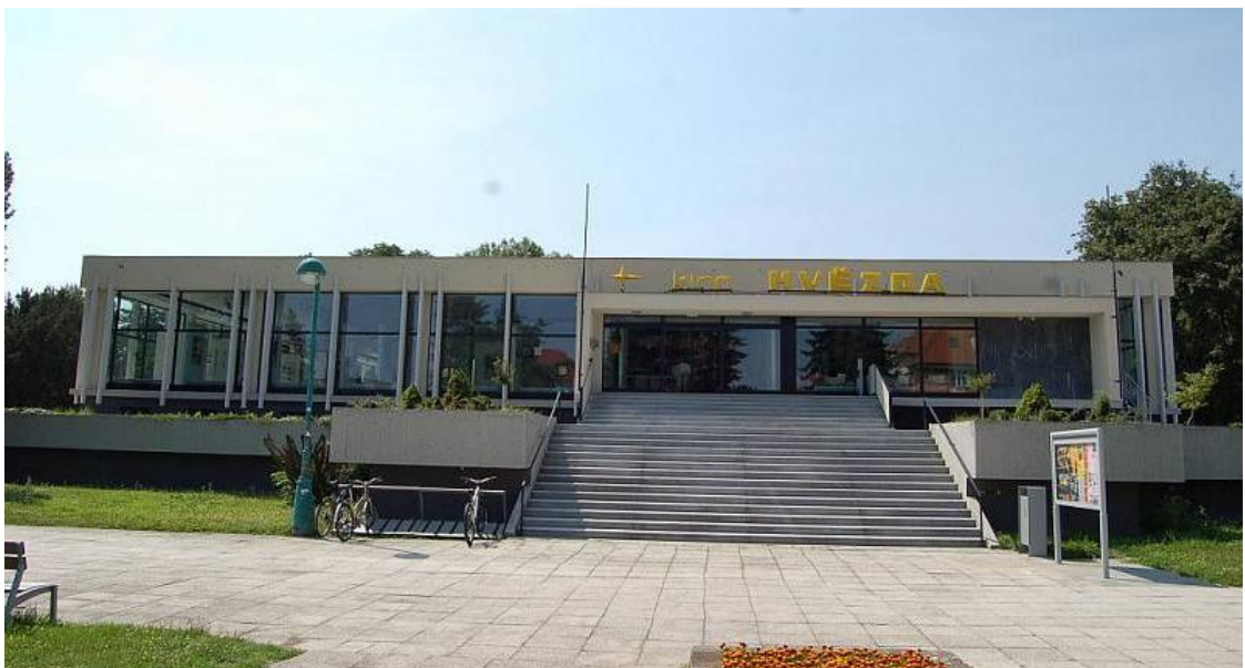
Obrázek 2 – Kino Hvězda po rekonstrukci Zdroj: Fotodokumentace města Uherské Hradiště
