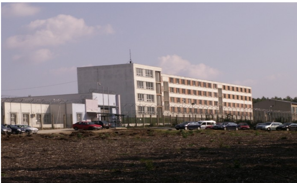
Pohled na věznici Rapotice (ubytovna)
