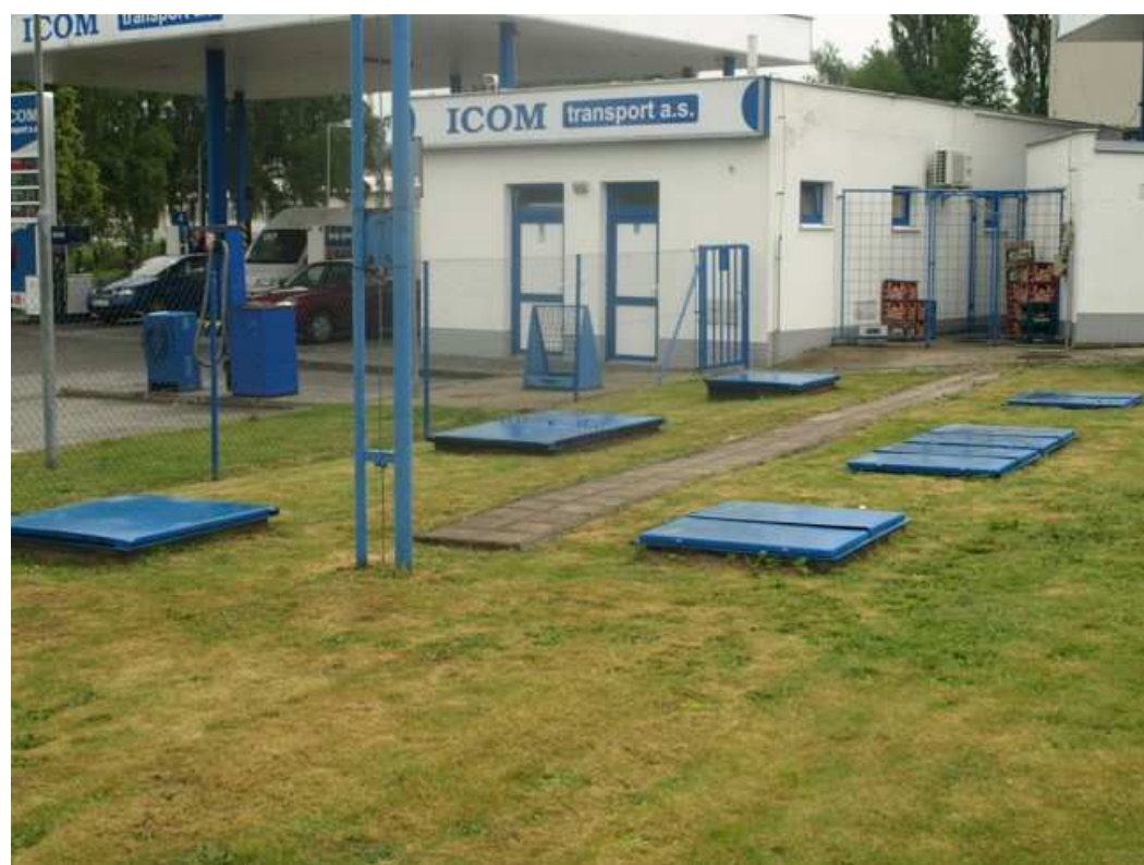
Obr. 16 Nádrže na ropné produkty
