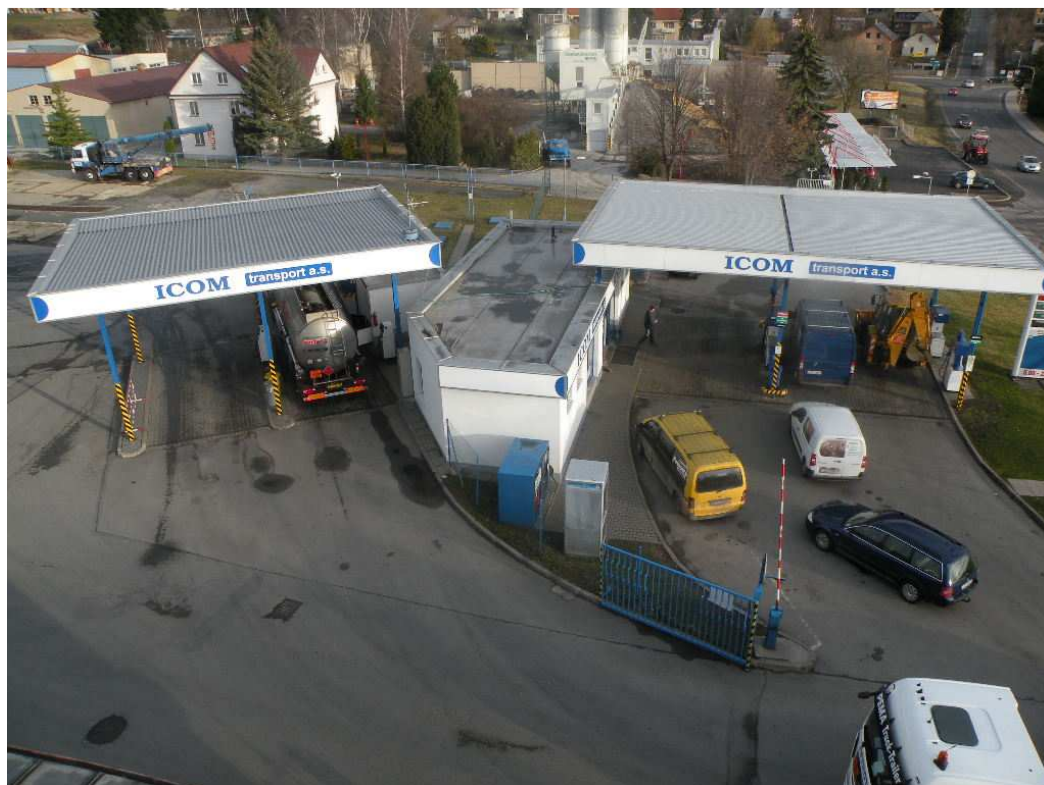
Obr. 14 Čerpací stanice se záchytnou jímkou
