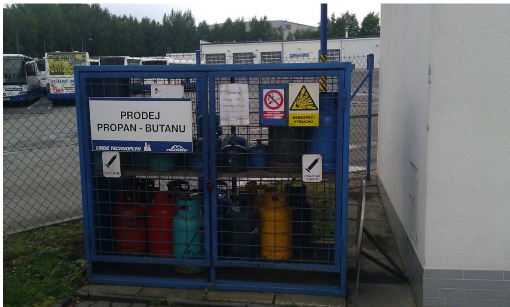
Obr. 22 Sklad propan-butan
