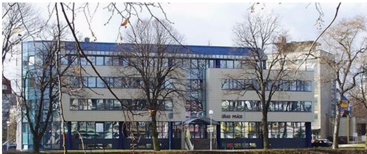
Obr. 2 Budova Úřadu práce ČR, krajská pobočka ve Zlíně, kontaktní pracoviště Kroměříž [23]
