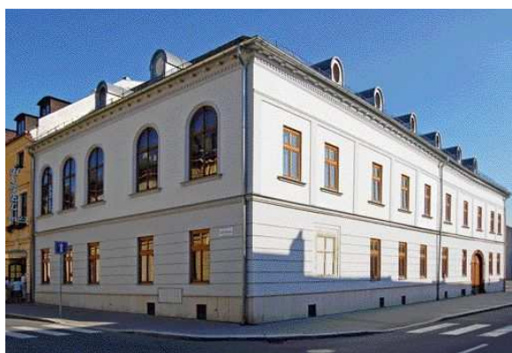
Obr. 3 Prozatímní rekonstrukce budovy
