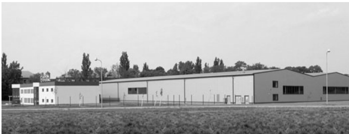
Obr. 13. Výrobní hala Kovona System v Českém Těšíně [10]
